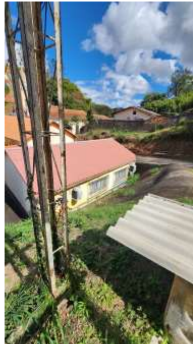
Foto 10. Vista do talude
