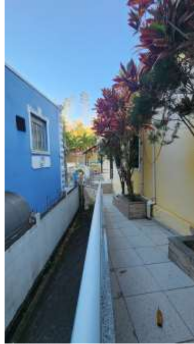
Foto 18. Jardineiras e passagem lateral – Canaleta de drenagem
