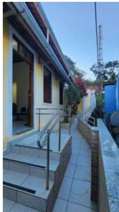
Foto 16. Escada de acesso e entrada principal
