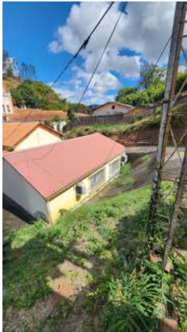
Foto 9. Vista do talude
