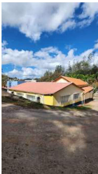
Foto 3. Vista geral da Câmara Municipal de Coronel Pacheco
