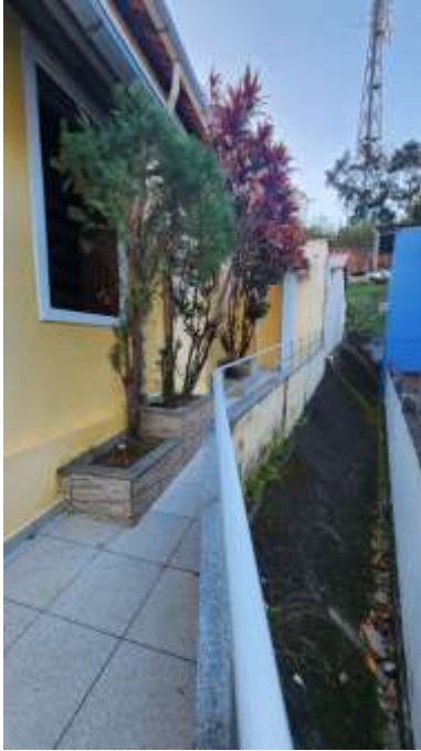
Foto 17. Jardineiras e passagem lateral – Canaleta de drenagem
