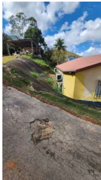
Foto 8. Vista do talude
