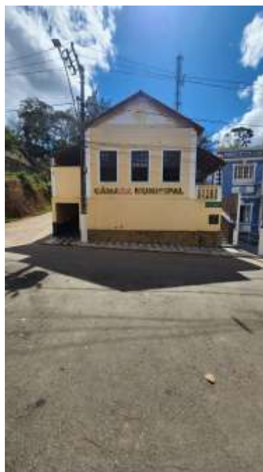
Foto 2. Fachada frontal da Câmara Municipal – vista geral
